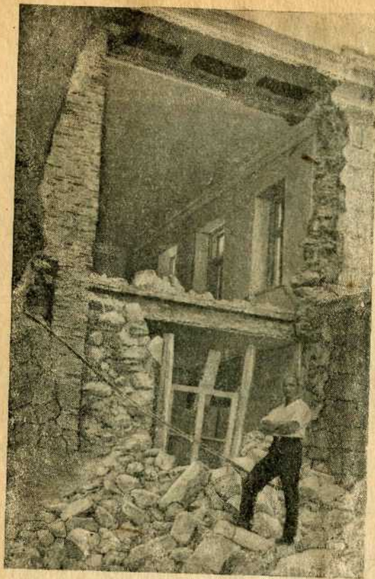
Разрушенный дом в Ялте.
