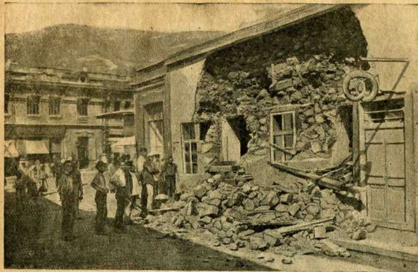
Разрушенный дом в Ялте.
