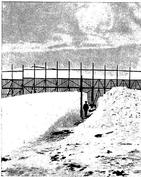
Промѣръ сугроба снѣга съ подвѣтренной стороны, по сдѣланному въ сугробѣ прорѣзу.
