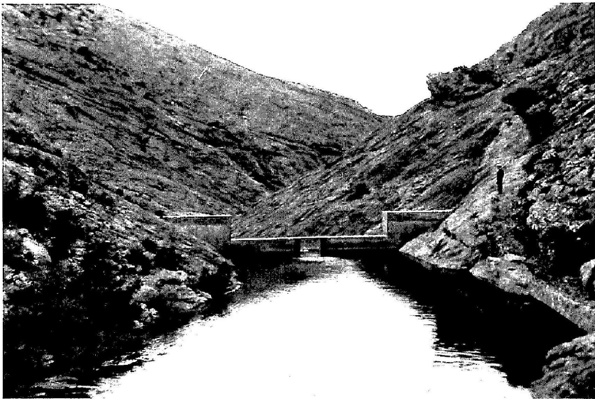
Водомѣрный постъ на р. Аянѣ. Видъ съ верховой стороны.
