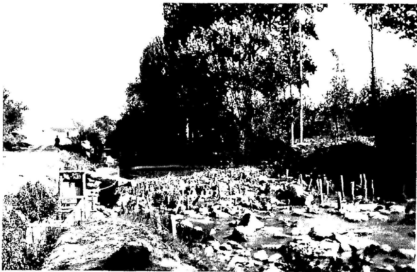
Водоподъемная плотина изъ камней и кольевъ и арыкбашъ съ щитовымъ затворомъ на р. Качѣ.
