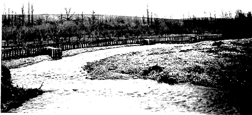
Укрѣпленіе частными владѣльцами береговъ досчатыми заборами и бентами на р. Салгирѣ.
