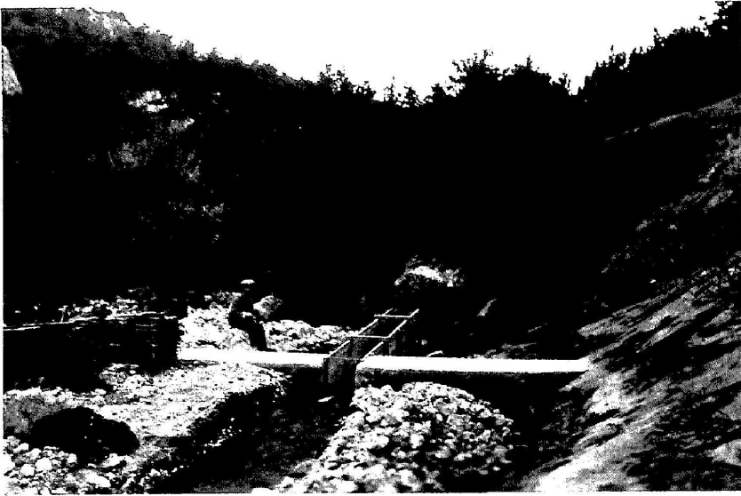
Верхний водомѣрный постъ на р. Кизиль-Коба послѣ постройки. На переднемъ планѣ видна расчищенная въ выносахъ канавка, подводящая воду къ желобу.
