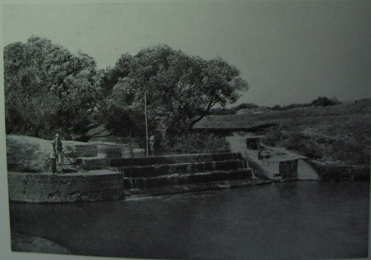
Водосливная плотина при водохранилищѣ на ст. Сарабузь.
