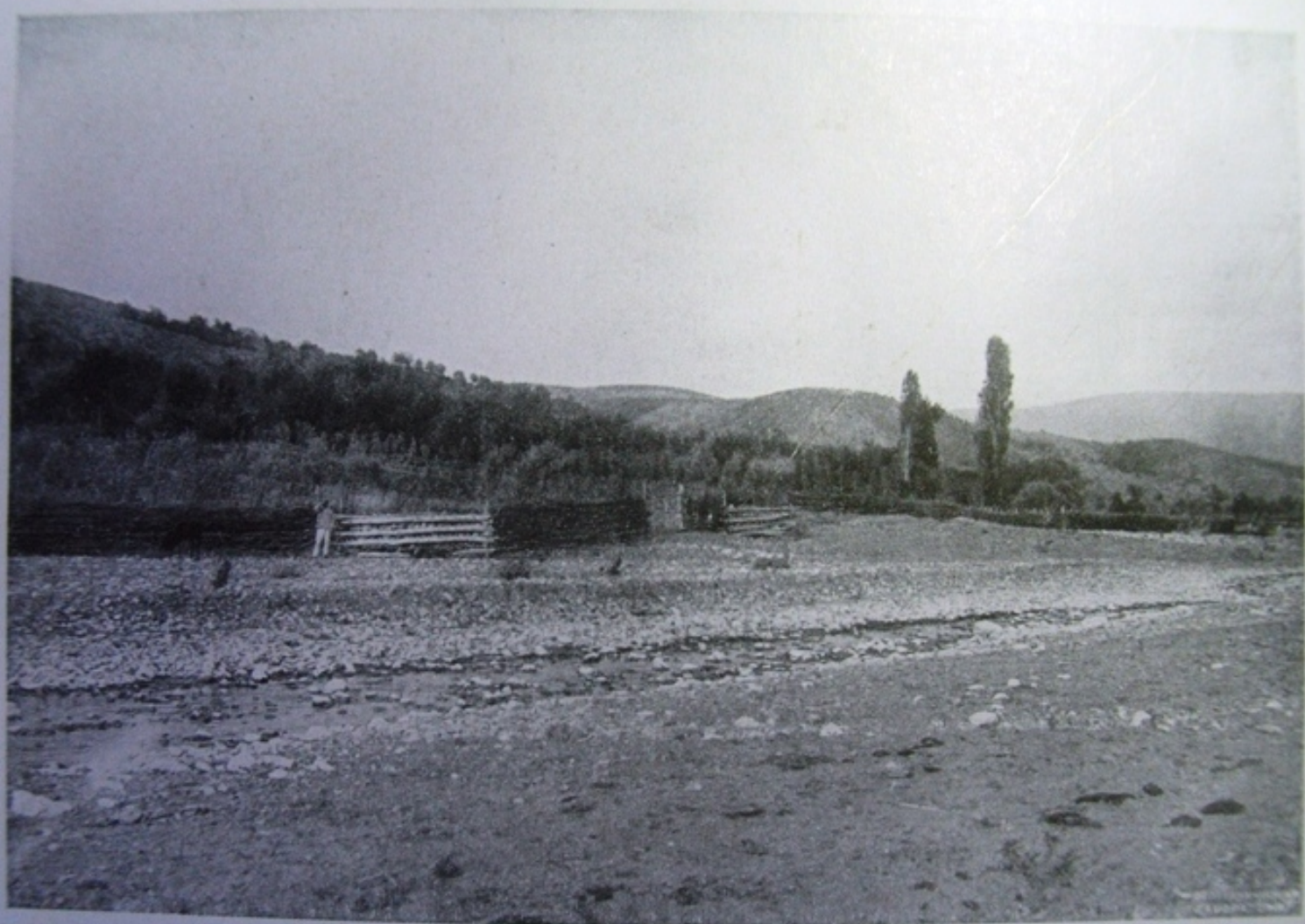
Постановка бентовъ и шпоръ по берегамъ Узень-Баша.
